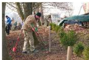
setzen eines neuen Zaunes - Friedhof
