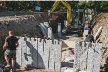
Setzen einer Stelenwand
