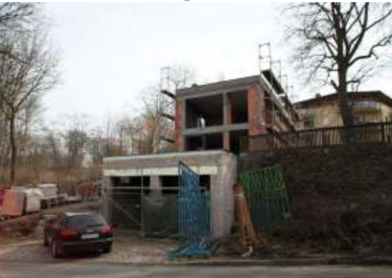
Der Neubau entsteht
