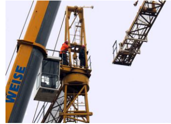
06.03. Der Kran wird montiert
