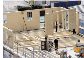
25.06. Erste Wände stehen
