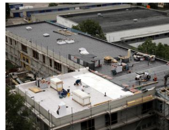
21.08. Dachdecker am Werk
