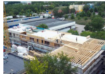
16.07. Das Dach nimmt Form an
