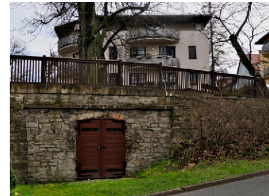
Eingang z. ehemaligen Eiskeller
