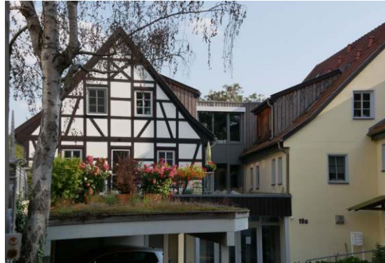
Foto: Mühlenkomplex - „Pappenbude“ nach der Renovierung
