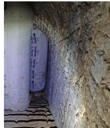
Stützen für die Drei Gleichen Foto: Fam. Herbst / Höck
